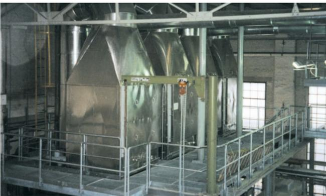
2 Dual-SCR-DeNO<sub>x</sub> Systeme für S-Oel-Kessel je 56.00 Bm<sup>3</sup>/h
