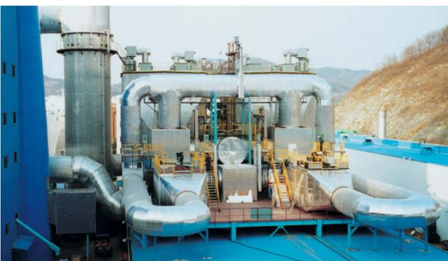
Dual-DeNO<sub>x</sub>-Katalysatoranlage für Glasschmelzwanne 304.600 m<sup>3</sup>/h
