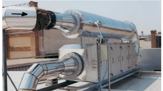
DeNO<sub>x</sub>-Katalysatoranlage für Dieselmotor 14.300 m<sup>3</sup>/h
