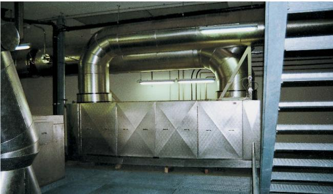
Katalysatoranlage zur Reduktion von NO<sub>x</sub>, CO, CmHn nach Sprengstoffverbrennung 28.500 m<sup>3</sup>/h
