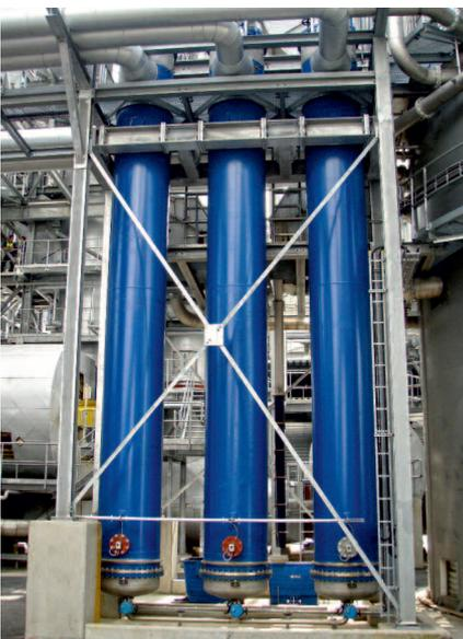
4 MW Wasser/Wasser-WT für Fernheizung mit abnehmbaren Kopfdeckeln
