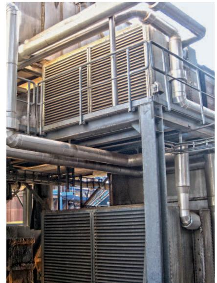
Wasser/Luft-WT für Verbrennungsluftvorwärmung; 71.000 m<sup>3</sup>/h; 1,56 MW
